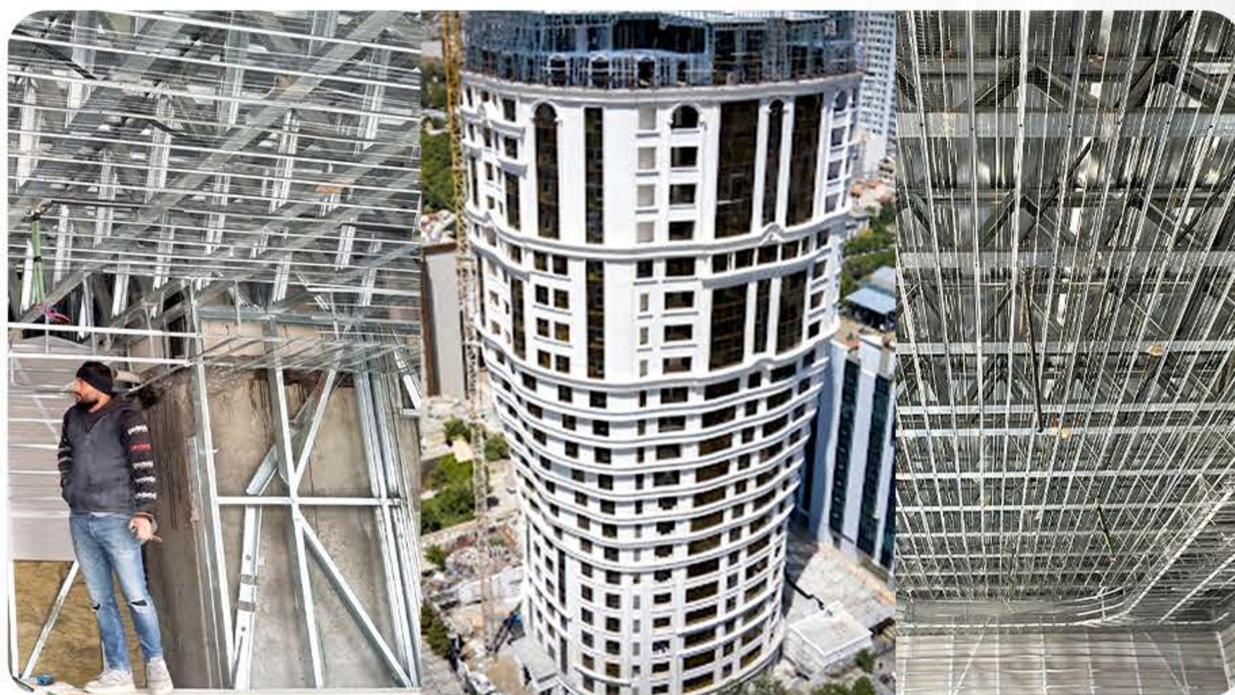
پوشش سقف و دیواره LSF - مشهد ، برج الیزه دو
